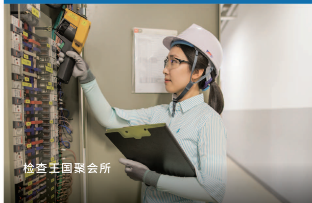
维修保养培训
